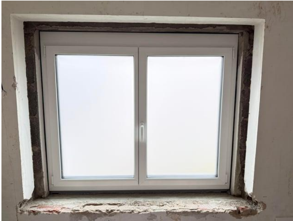
Beispielhafter Fenstertausch inkl. Fensterbank und Laibung
